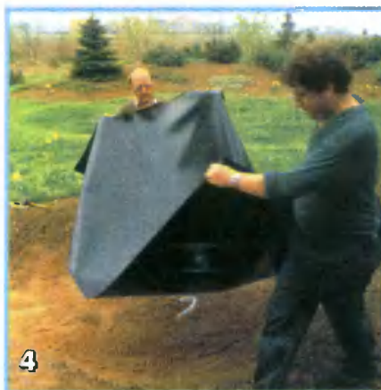
4 Пленку сначала настилают в зоне источника. Труба для перекачки воды должна быть уже на месте
