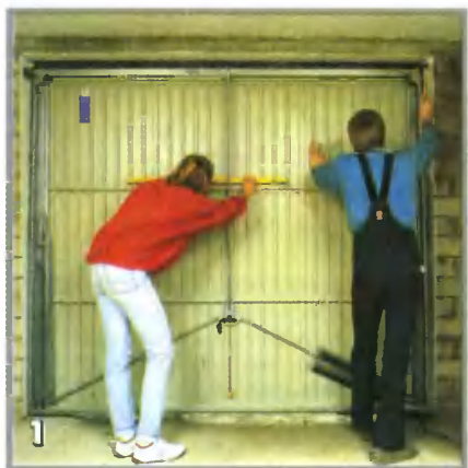
После удаления цементной стяжки ставят ворота, тщательно выверяют по горизонтали и в этом положении временно закрепляют клиньями
