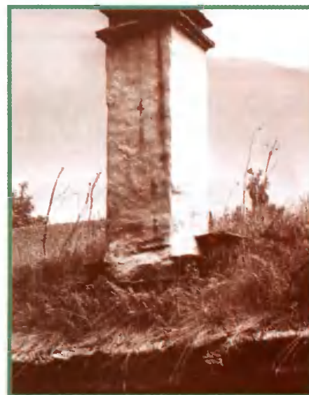
Дымовая труба с выступающими каменными плитами
