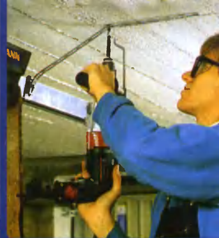
Ремонт гаража , с. 49
