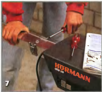
С обеих сторон к направляющей шине шурупами-саморезами фиксируют фурнитуру, необходимую для ее крепления к потолку
