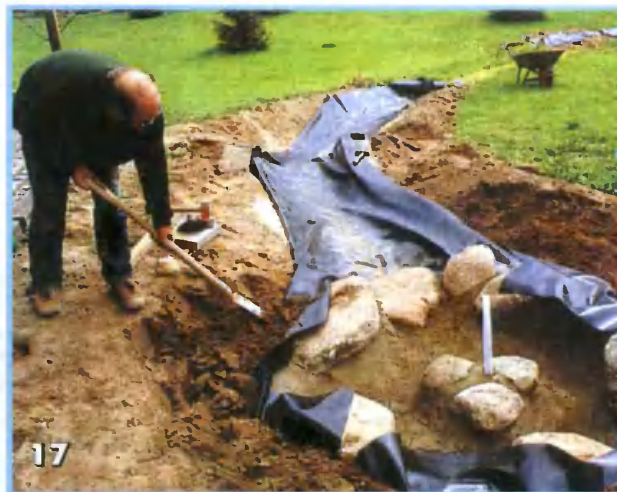
Под бассейн-источник вырыли достаточно большой котлован. Теперь, когда форма бассейна определена, его снова заполняют грунтом
