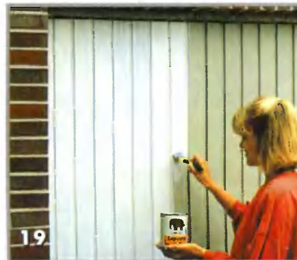
19 Обшивка ворот из листовой стали уже загрунтована на заводе. Остается только нанести на нее краску
