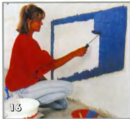
16 Чтобы краска не попала под пленку, валик при покраске перемещают от краев фигуры к середине
