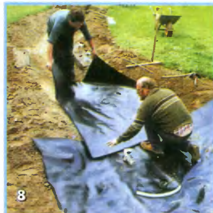
8 Прежде чем окончательно уложить и соединить полосы пленки, их необходимо тщательно подогнать друг к другу
