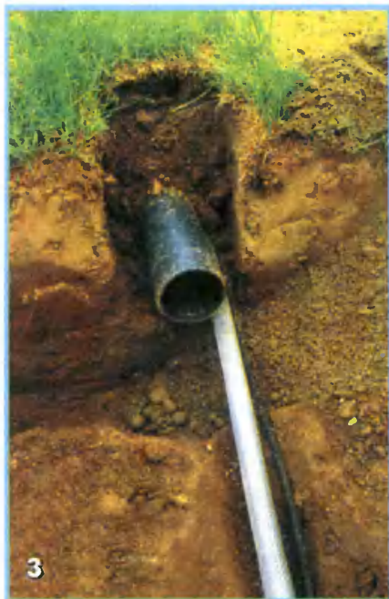
3 На определенном отрезке ручей течет под газоном. На выходе воды из-под газона видны проточная труба, труба для перекачки воды и электрокабель
