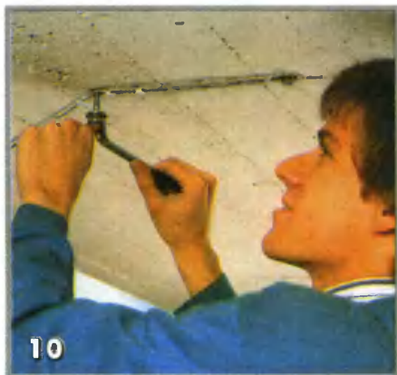
Не забудьте подложить под головки саморезов зубчатые шайбы, иначе крепление будет постепенно расшатываться
