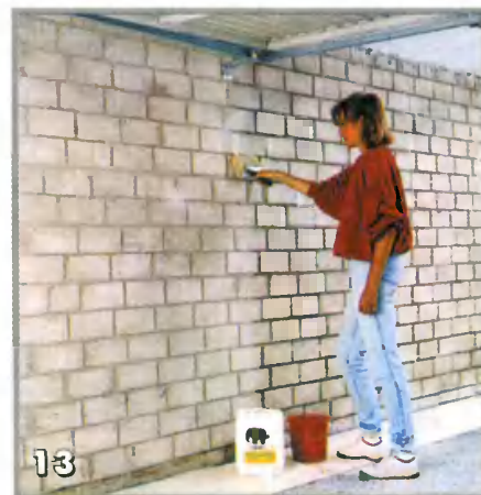
На стены, очищенные от потеков раствора и пыли, наносят грунтовку
