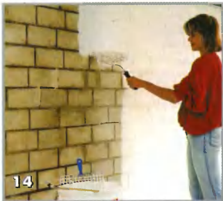
14 Грунтовка, глубоко проникающая в поры материала основы, обеспечивает прочную связь между основой и покрытием. Краску наносят валиком
