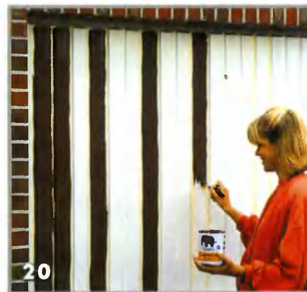
20 Когда светлая краска полностью высохнет, наклеенные защитные ленты снимают и красят ребра гофров темно-бурым лаком под цвет кирпичной кладки гаража
