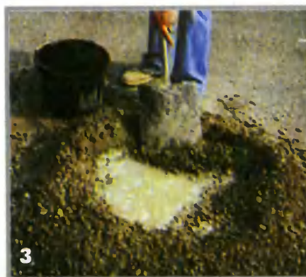
3 В смеси заполнителя с цементом делают воронку, в которую заливают воду. После этого массу перемешивают
