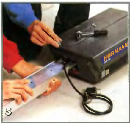
При сборке приводного механизма прежде всего соединяют муфтой направляющую шину с приводным двигателем. Полумуфты соединяют болтами
