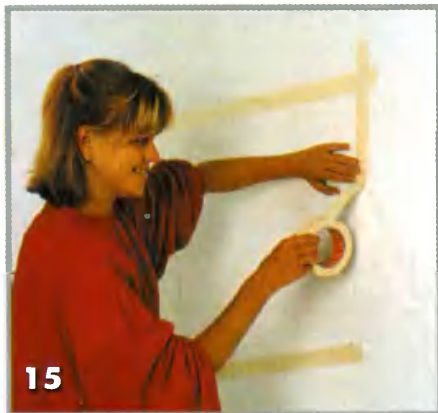
15 Контуры будущих параллелограммов и квадратов, нарисованных на стенах, обклеивают лентой
