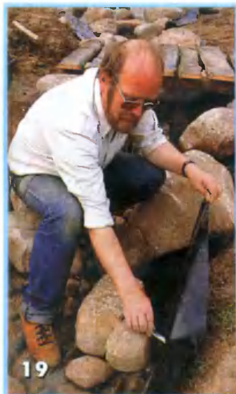
Выступающие края пленки обрезают, иначе ручей будет выглядеть не натурально
