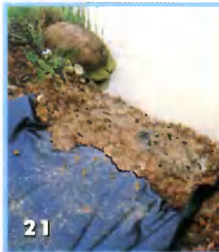
На переходе к естественному пруду пленку укладывают в глинистый грунт, у пленочного пруда-истока пленку сваривают
