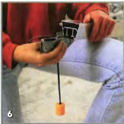
Вставляют каретку в направляющие канавки шины привода. Взаимодействие боковых проволочных скоб с концевыми выключателями проверяют в действии после монтажа привода
