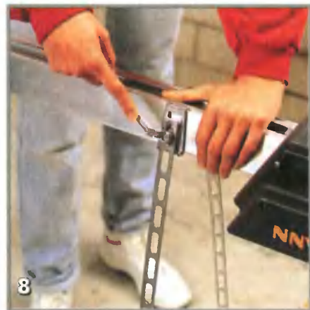
Соединение стальной перфорированной ленты с крепежными элементами на направляющей шине. Работу делать удобнее, если приводной механизм положить на козлы
