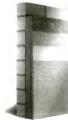
Рис. 6. Система наружного утепления «мокрого типа»
