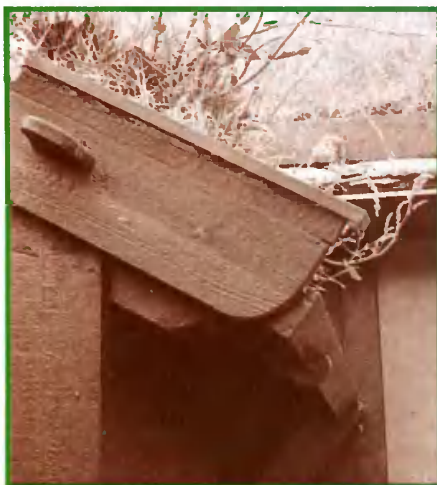
Ограждающая доска с деревянным водосточным желобом
