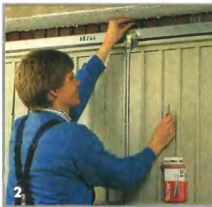
Не нарушая положения ворот, их крепят дюбелем \varnothing 10 мм, забивая его в стену по середине перекладины рамы
