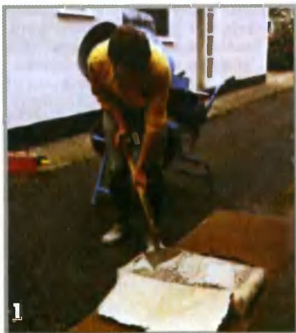
1 Чтобы не испортить газон, мешки с цементом целесообразно уложить на картон или пленку
