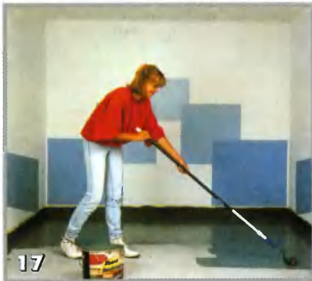
17 На предварительно подготовленный и просушенный пол наносят защитный слой покрытия
