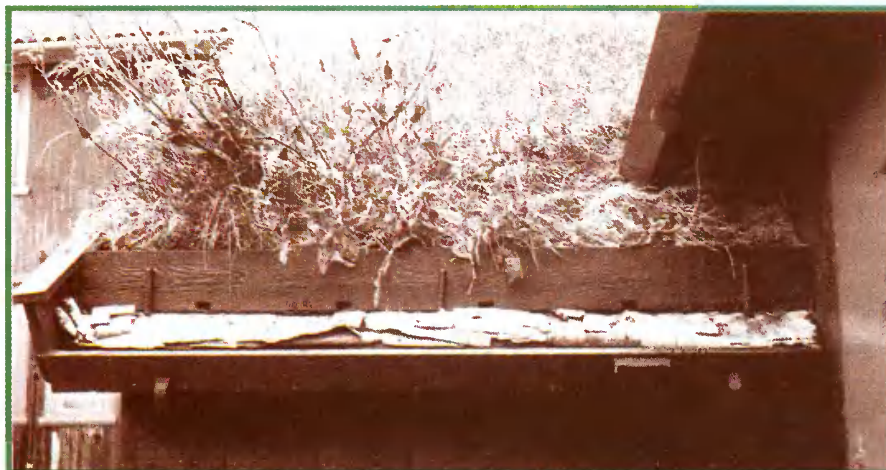
Свес с водосточным желобом, защищенный ветровой доской
