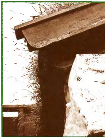
Ветровой элемент, укрытый горизонтально уложенной доской
